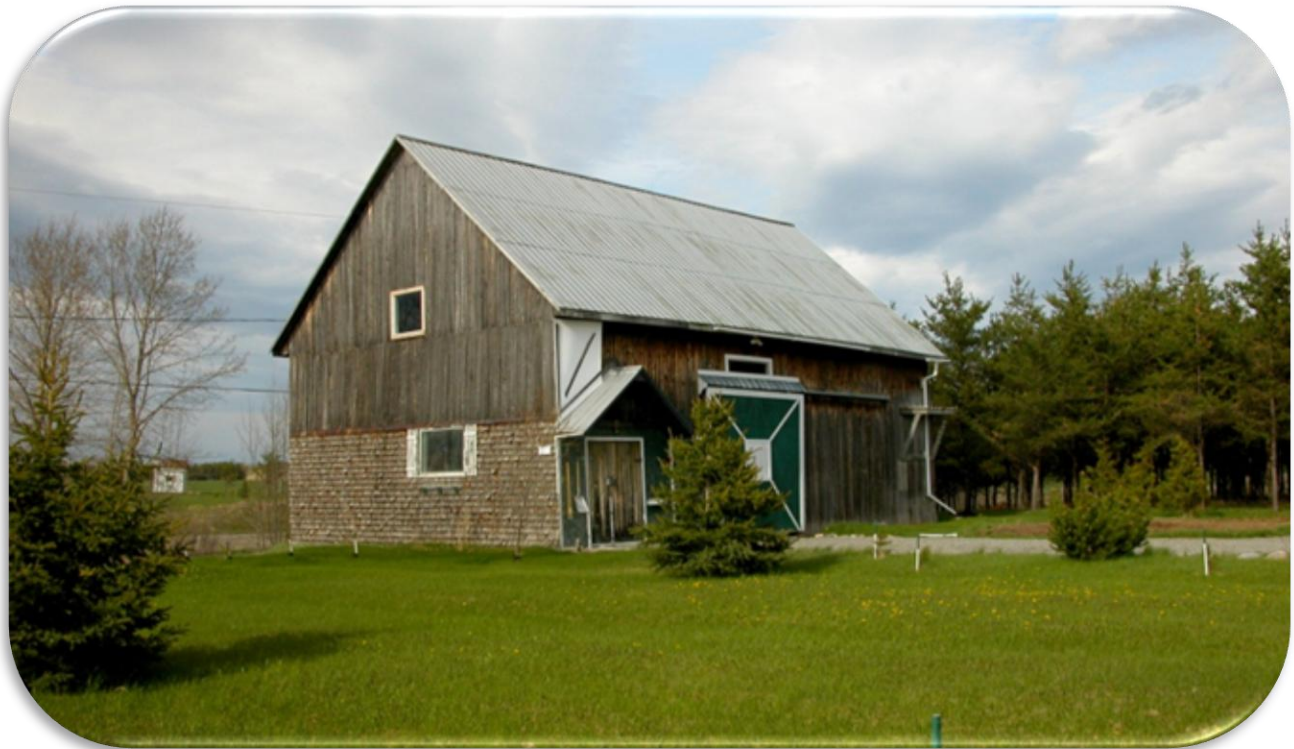
Grange du 1450, 6e-et-7e Rang Est de La Sarre, faisant partie de l'inventaire du patrimoine bâti de La Sarre, Photo : Manon Sarthou, Devamco, 2008 (Français et anglais à expliciter)
